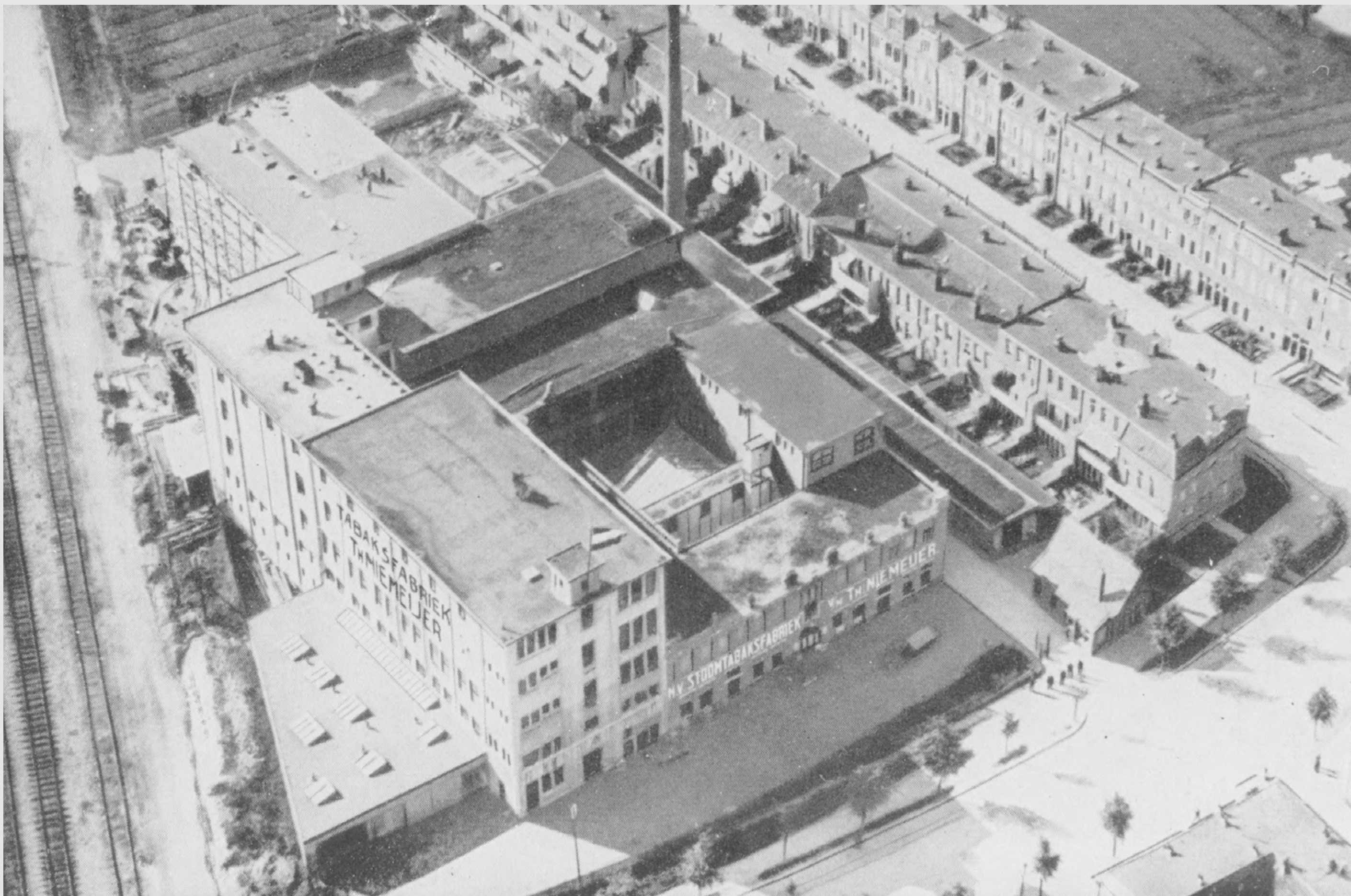
De fabriek in 1925, bron: Groninger archieven
