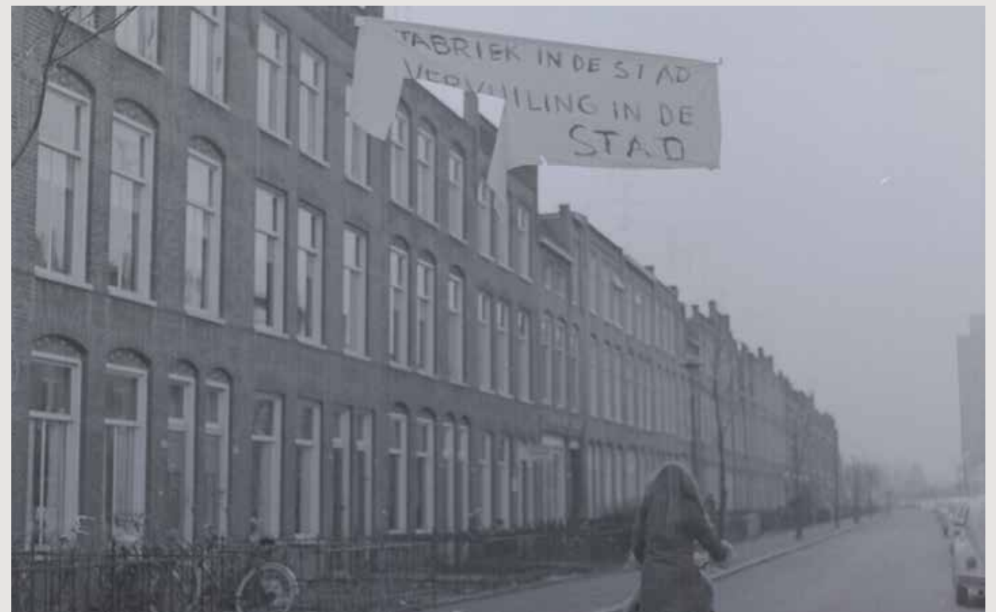
De fabriek in 1973, bron: Groninger archieven
