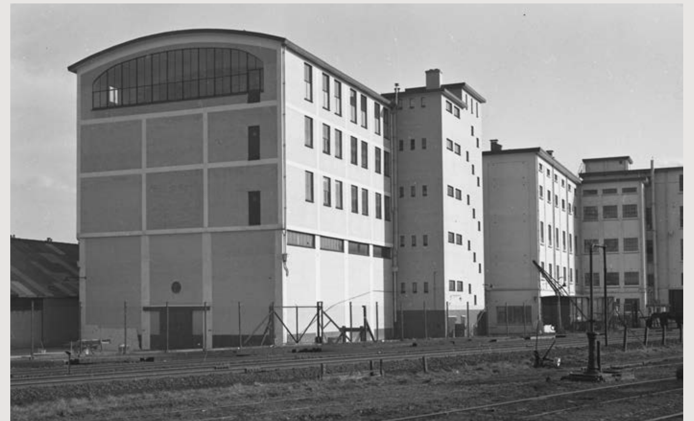
De fabriek in 1950, bron: Groninger Archieven
